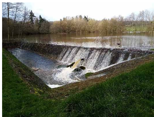
Barrage des Mesnuls
